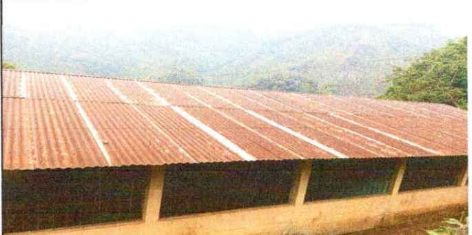
Foto 6: LA MAYOR PARTE DE LAMINAS PRESENTA PERFORACIONES
