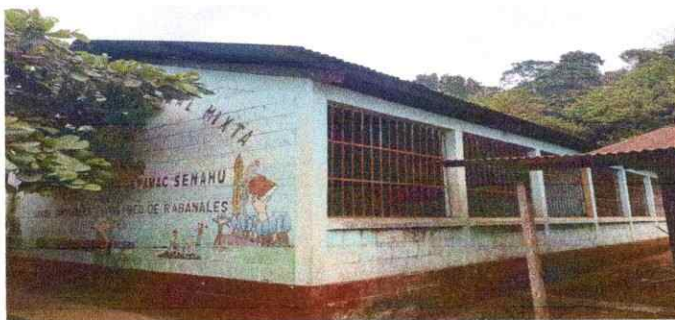
Foto 3: MODULOS SIN VENTANAS
